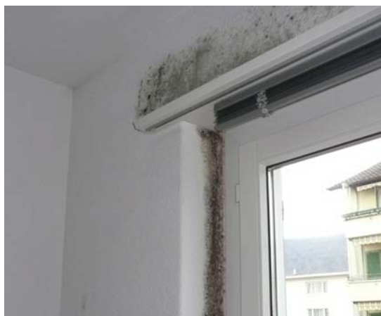
Typische Stellen mit Wärmebrücken und Schimmelschäden
